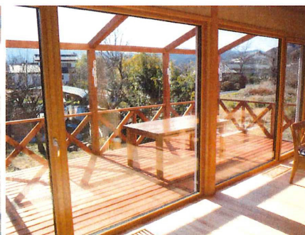
1階の南面と東面にはトリプルガラスを使用した大きな開口部。十津川産の杉をドイツに輸出し、ドイツにて加工、輸入している(U=0.6W/m 2 ・K)。写真左は高橋社長。
