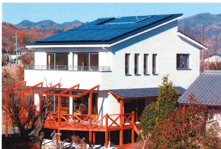
高橋建築による設計・施工の「秩父パッシブハウス」。太陽光発電(8kw)と真空管太陽熱温水器で自然エネルギーを利用し、プラスエネルギーハウスを実現。
